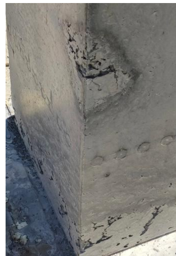
2-сурет – Бетондағы пайда болған ақаулардың сыртқы түрлері
